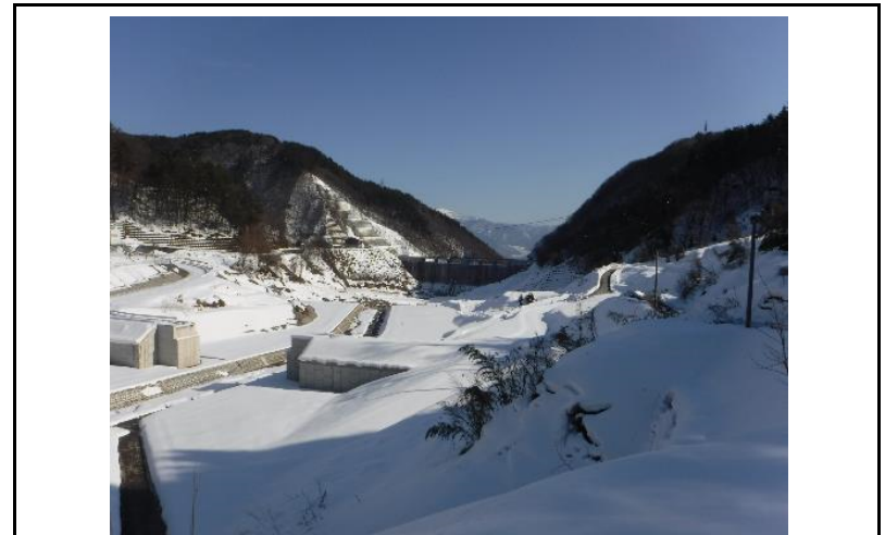
4 貯水池(上流からの全景)
