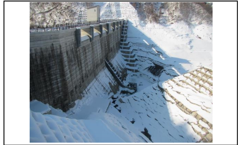
2 ダム上流面(左岸から)
