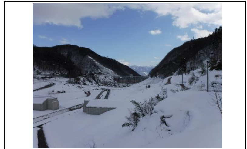
4 貯水池(上流からの全景)
