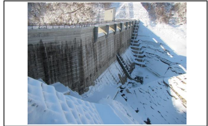
2 ダム上流面(左岸から)
