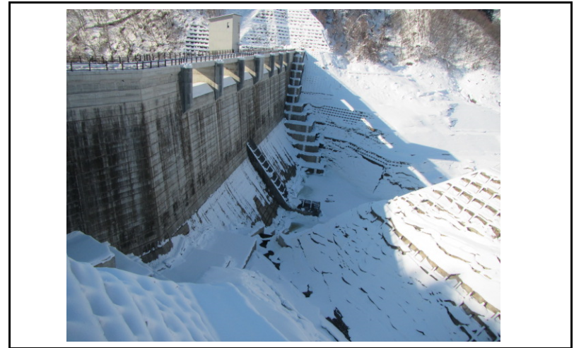
2 ダム上流面(左岸から)
