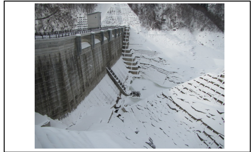
2 ダム上流面(左岸から)
