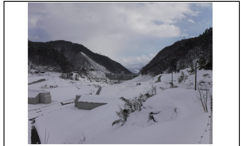
4 貯水池(上流からの全景)
