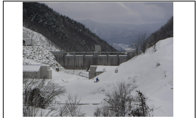
4 貯水池(上流からの全景)
