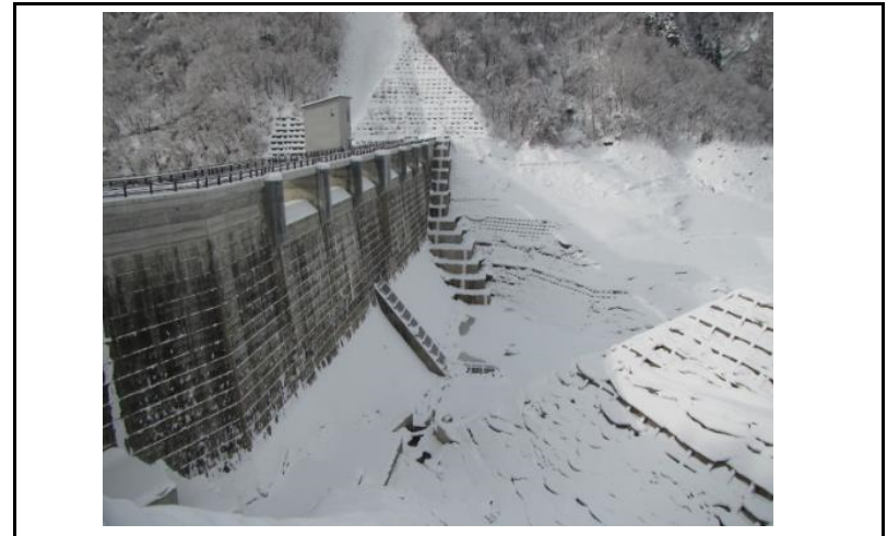
2 ダム上流面(左岸から)
