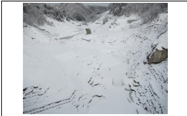
3 貯水池(ダムから上流)
