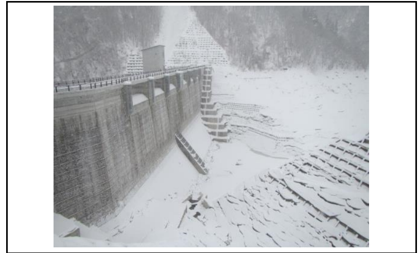
2 ダム上流面(左岸から)
