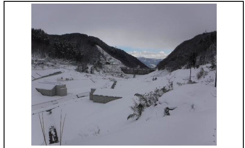
4 貯水池(上流からの全景)
