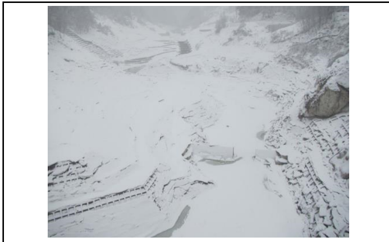
3 貯水池(ダムから上流)
