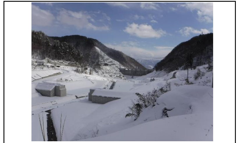
4 貯水池(上流からの全景)
