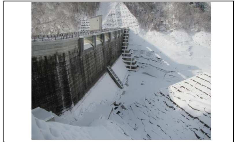
2 ダム上流面(左岸から)
