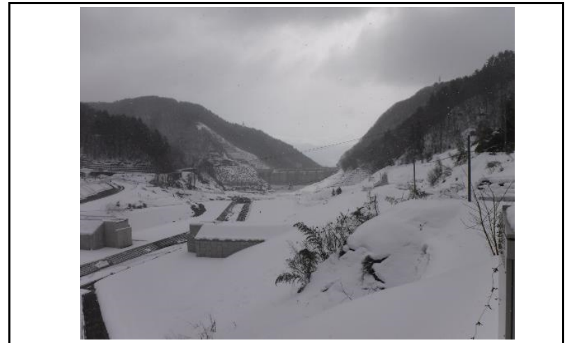
4 貯水池(上流からの全景)
