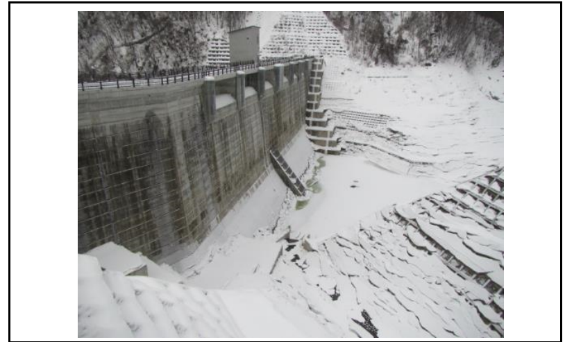
2 ダム上流面(左岸から)
