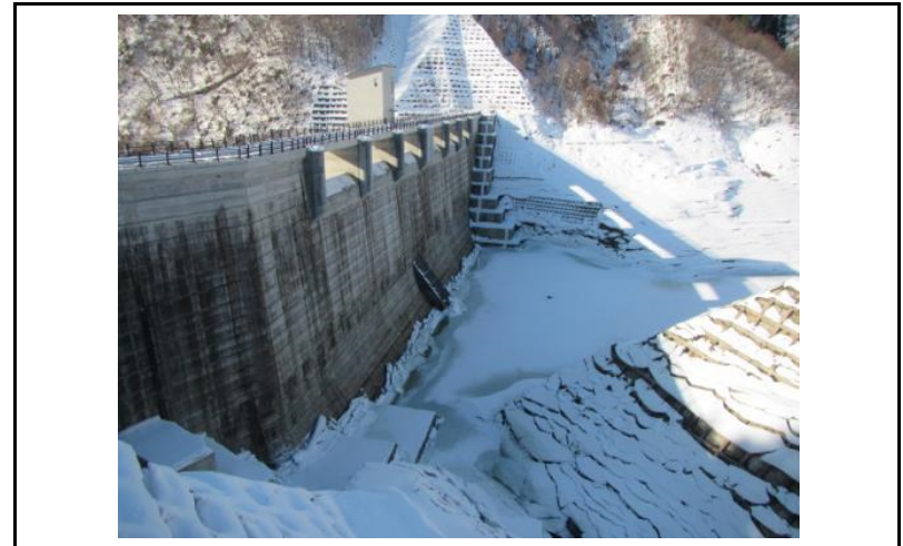
2 ダム上流面(左岸から)
