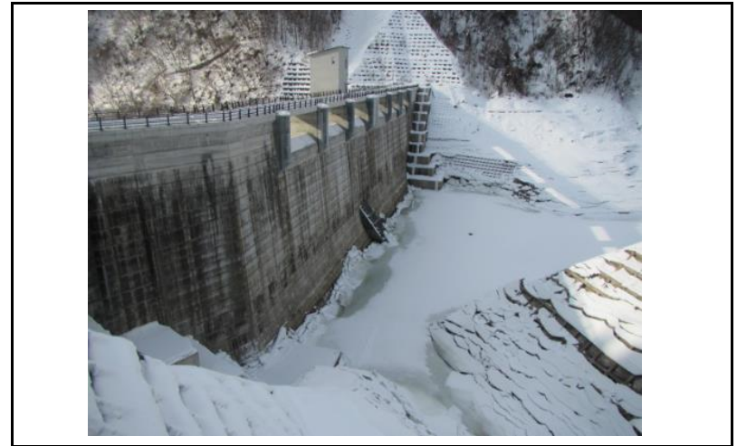
2 ダム上流面(左岸から)
