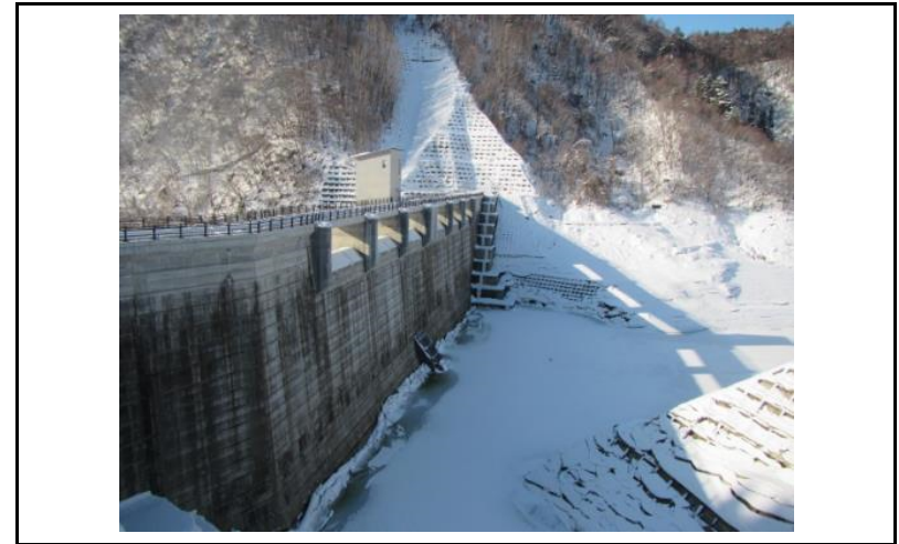
2 ダム上流面(左岸から)
