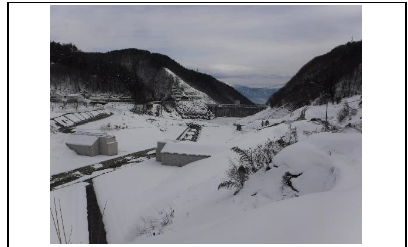
4 貯水池(上流からの全景)
