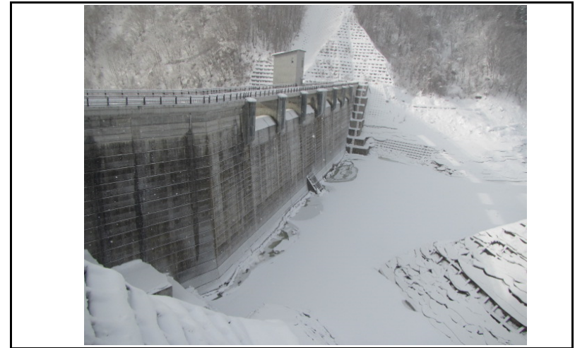
2 ダム上流面(左岸から)
