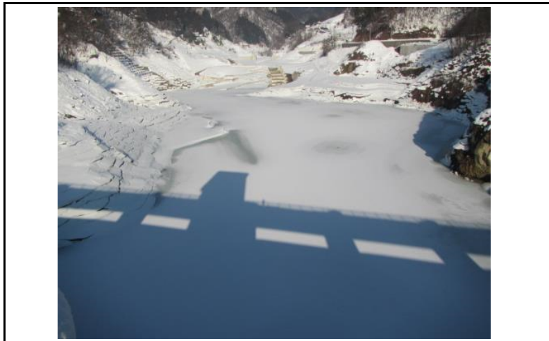
3 貯水池(ダムから上流)
