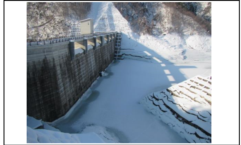
2 ダム上流面(左岸から)
