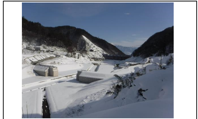
4 貯水池(上流からの全景)
