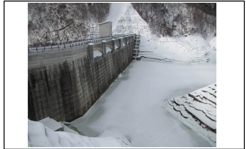
2 ダム上流面(左岸から)
