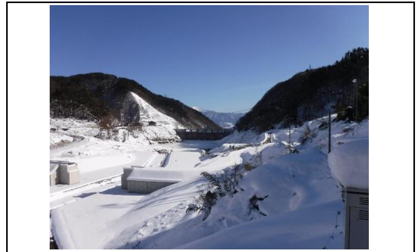
4 貯水池(上流からの全景)
