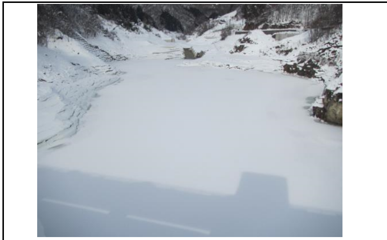
3 貯水池(ダムから上流)
