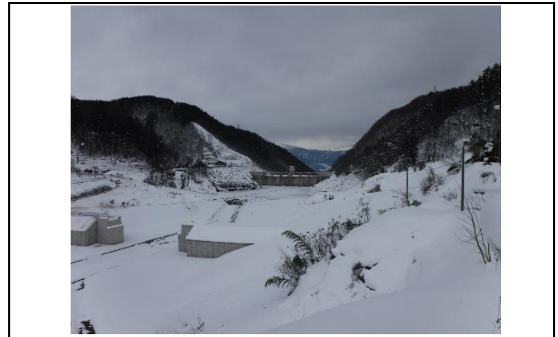
4 貯水池(上流からの全景)
