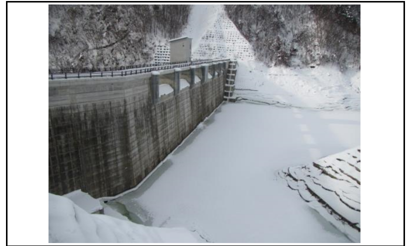
2 ダム上流面(左岸から)
