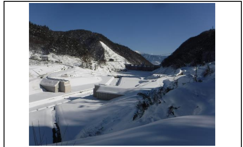
4 貯水池(上流からの全景)
