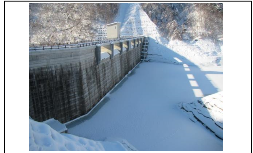
2 ダム上流面(左岸から)
