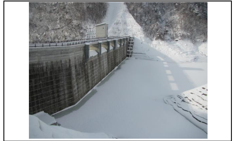
2 ダム上流面(左岸から)
