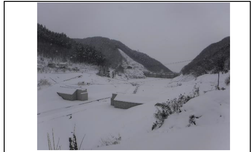
4 貯水池(上流からの全景)
