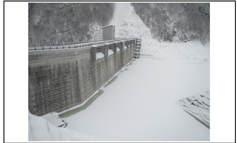
2 ダム上流面(左岸から)
