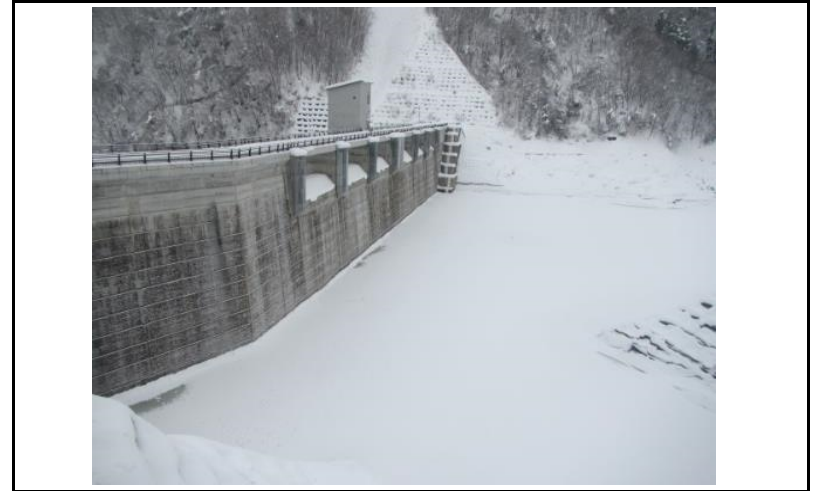
2 ダム上流面(左岸から)
