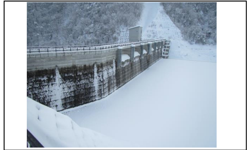
2 ダム上流面(左岸から)
