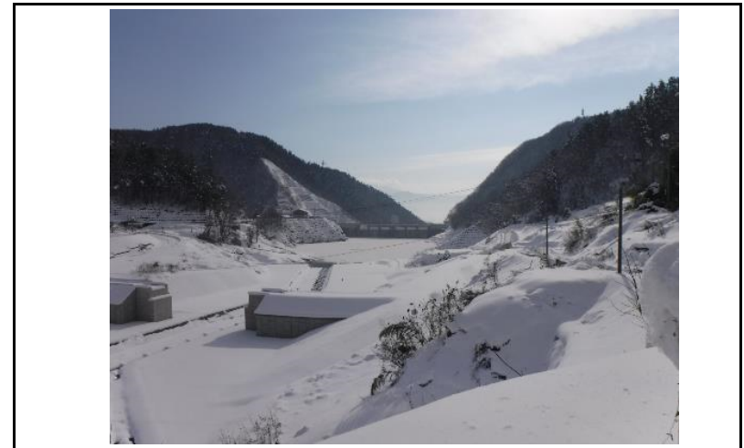
4 貯水池(上流からの全景)
