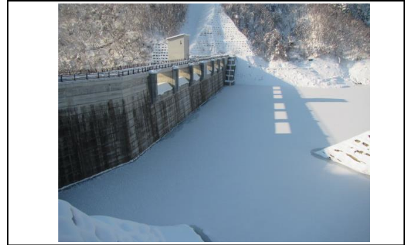
2 ダム上流面(左岸から)
