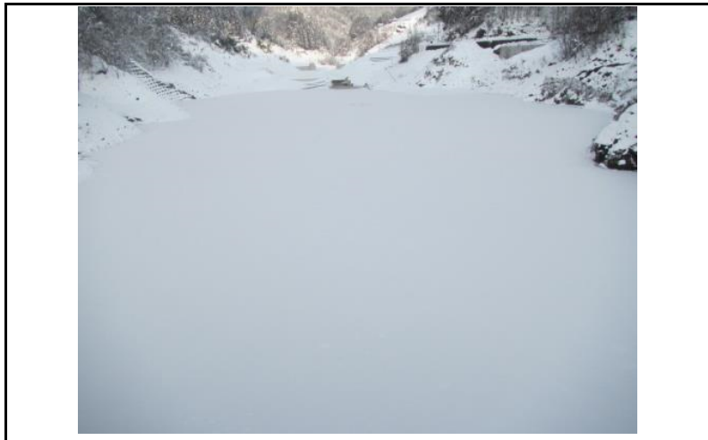
3 貯水池(ダムから上流)
