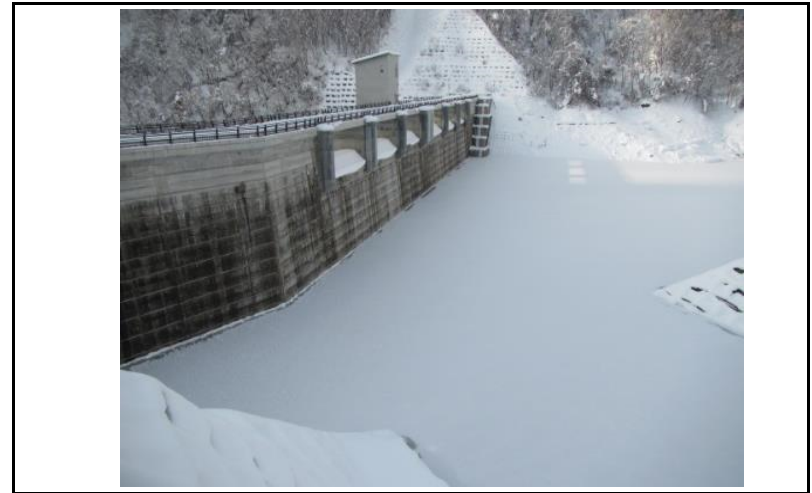
2 ダム上流面(左岸から)
