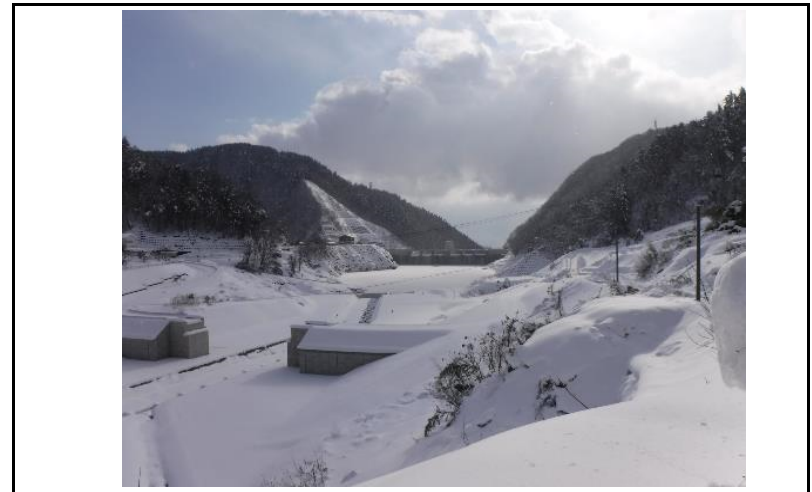
4 貯水池(上流からの全景)
