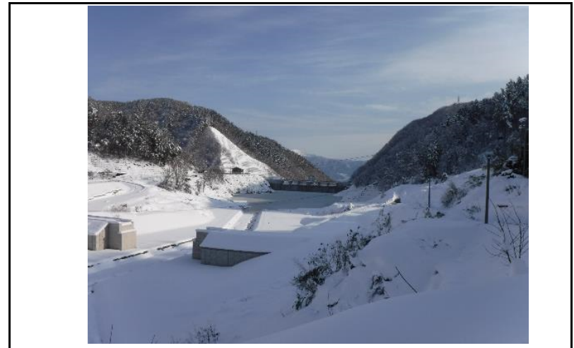
4 貯水池(上流からの全景)
