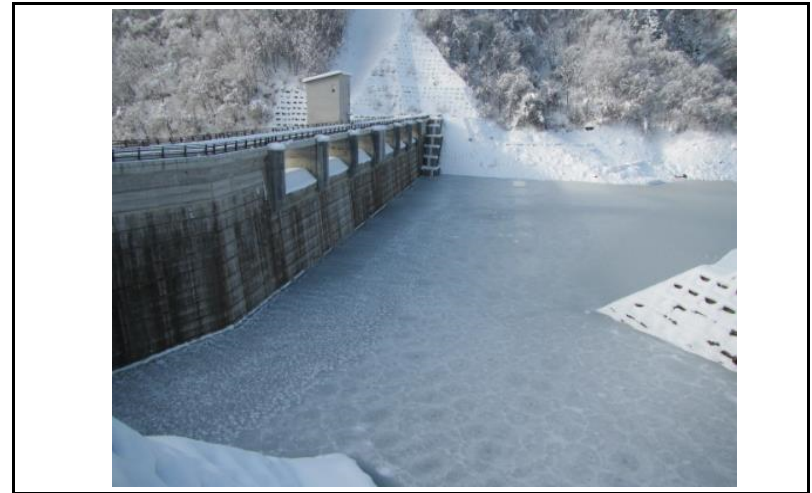
2 ダム上流面(左岸から)
