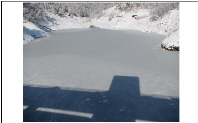
3 貯水池(ダムから上流)
