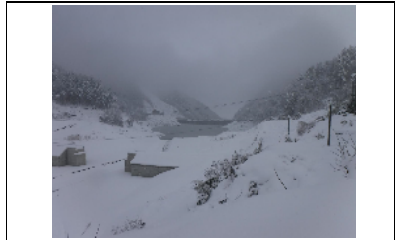
4 貯水池(上流からの全景)
