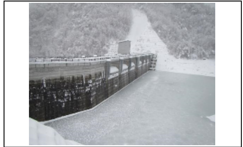
2 ダム上流面(左岸から)
