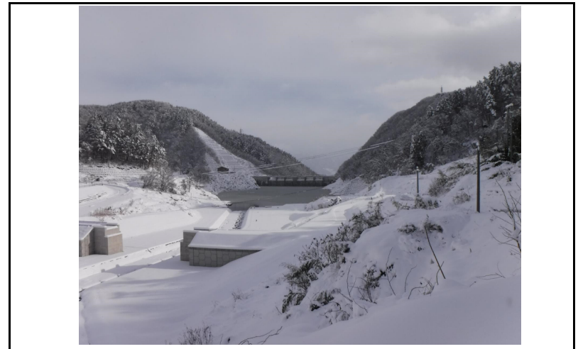
4 貯水池(上流からの全景)
