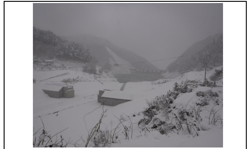
4 貯水池(上流からの全景)
