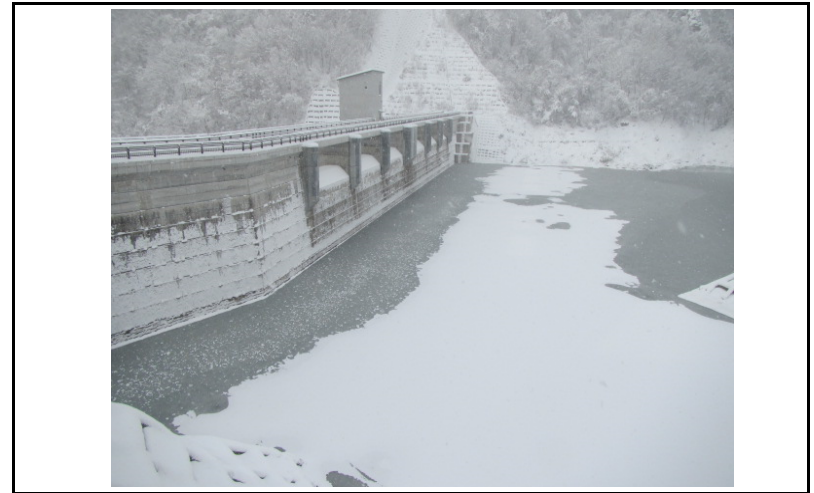
2 ダム上流面(左岸から)
