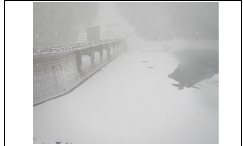
2 ダム上流面(左岸から)
