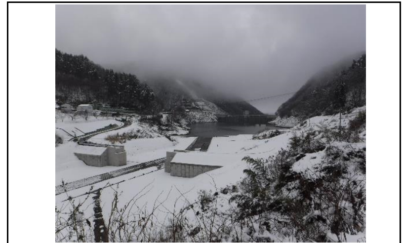
4 貯水池(上流からの全景)
