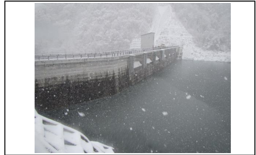
2 ダム上流面(左岸から)
