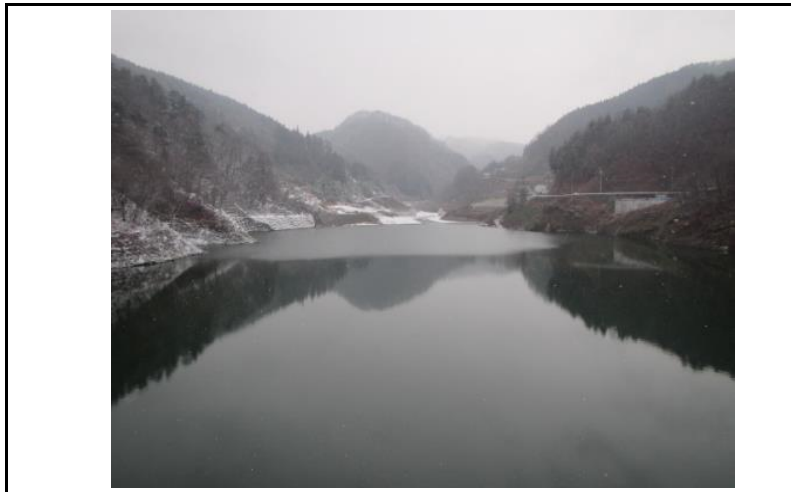
3 貯水池(ダムから上流)
