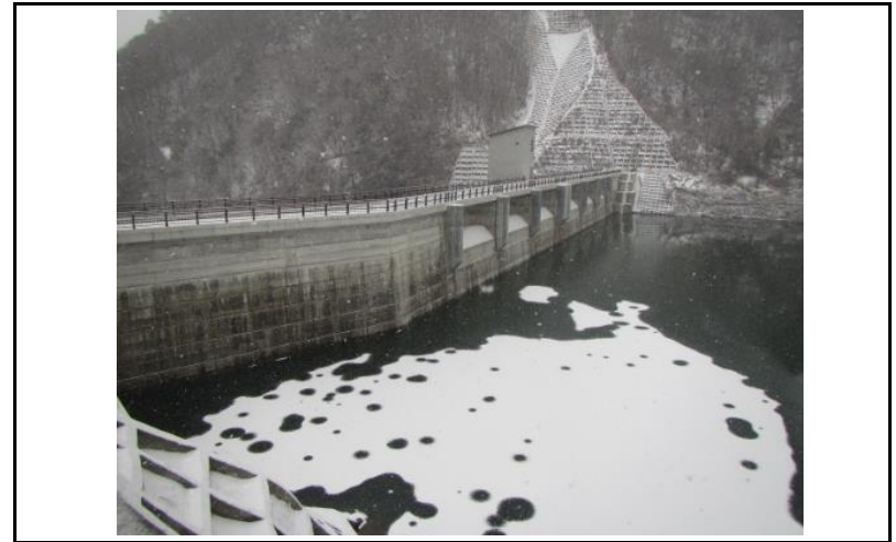
2 ダム上流面(左岸から)
