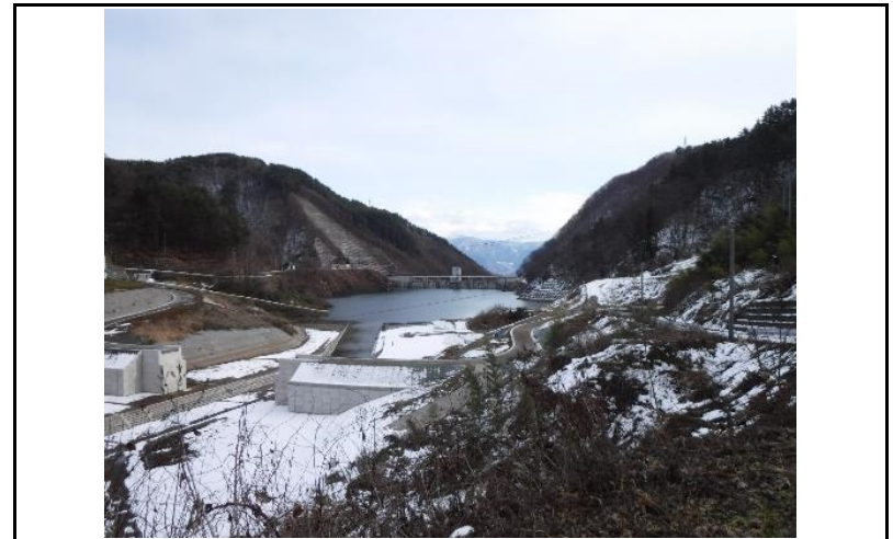
4 貯水池(上流からの全景)
