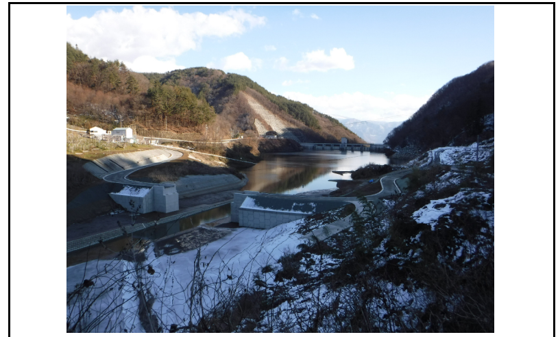
4 貯水池(上流からの全景)
