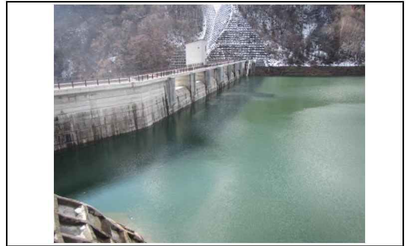
2 ダム上流面(左岸から)
