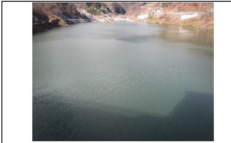
3 貯水池(ダムから上流)
