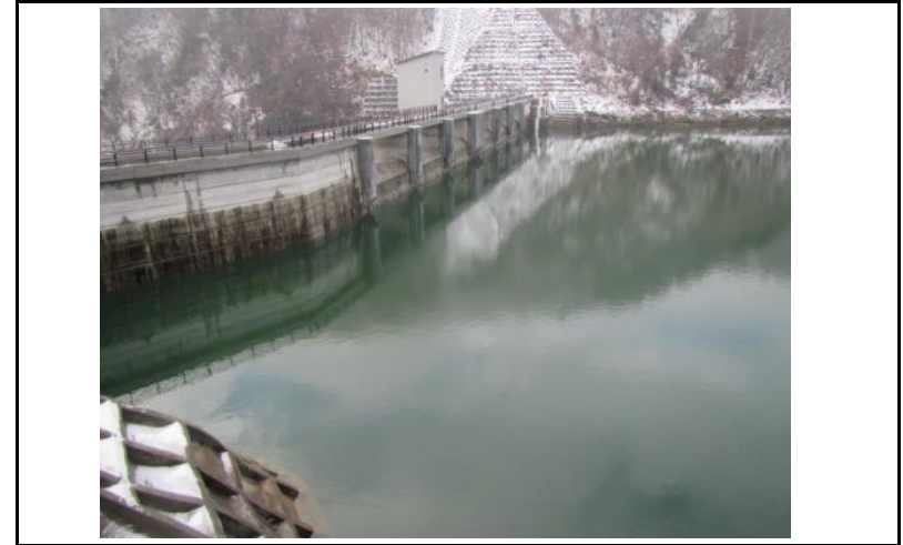
2 ダム上流面(左岸から)
