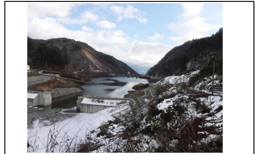
4 貯水池(上流からの全景)
