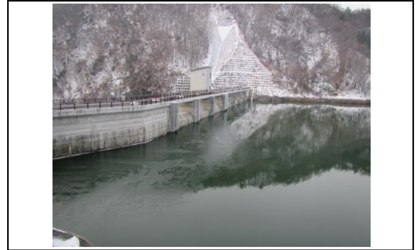
2 ダム上流面(左岸から)
