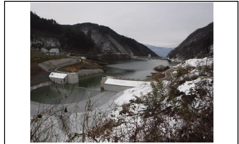
4 貯水池(上流からの全景)
