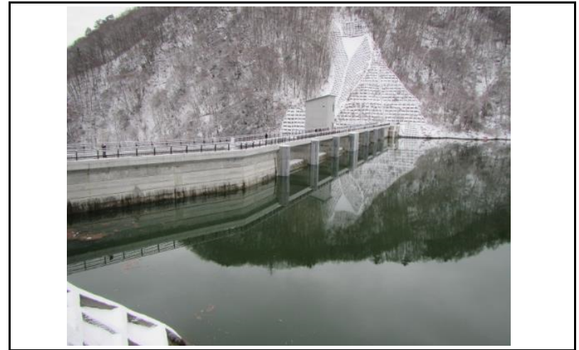
2 ダム上流面(左岸から)
