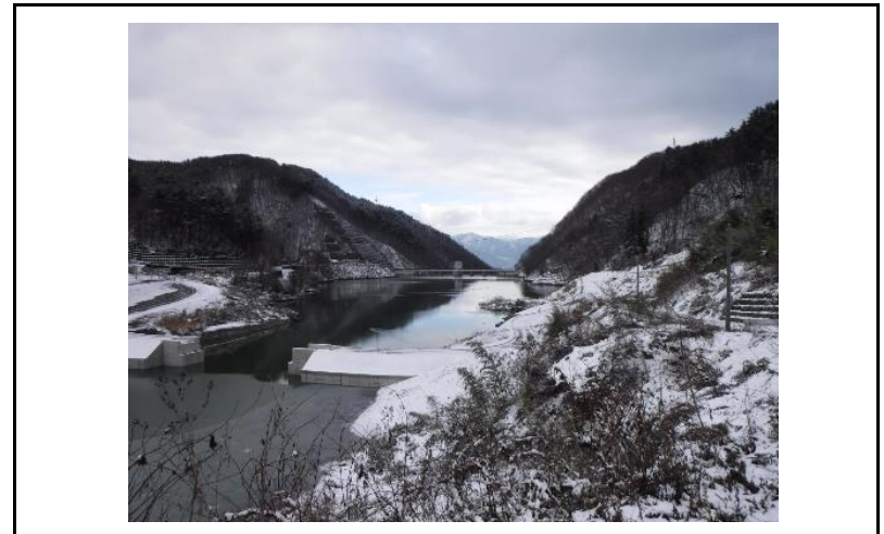
4 貯水池(上流からの全景)
