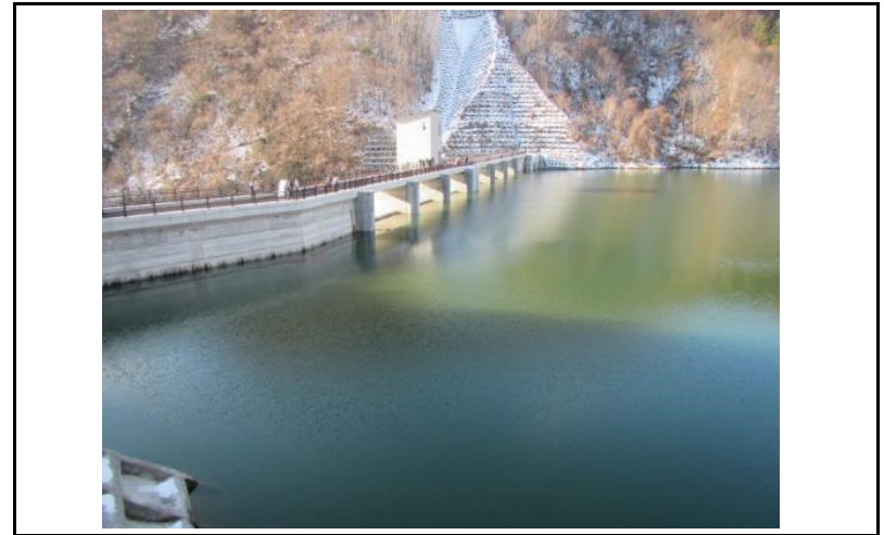
2 ダム上流面(左岸から)
