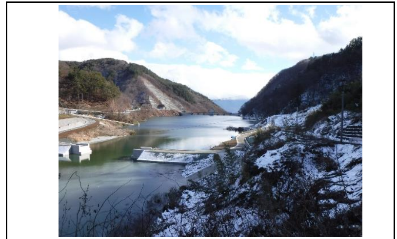
4 貯水池(上流からの全景)
