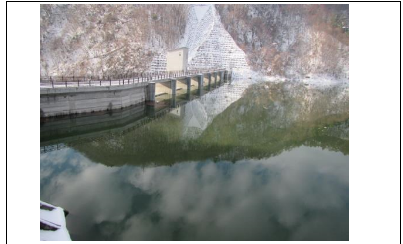
2 ダム上流面(左岸から)
