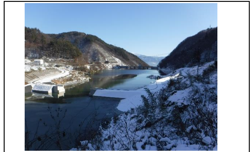
4 貯水池(上流からの全景)
