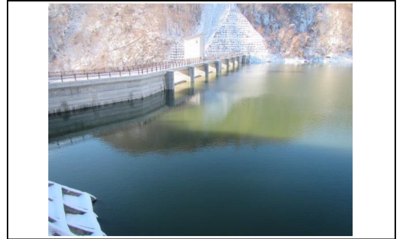
2 ダム上流面(左岸から)
