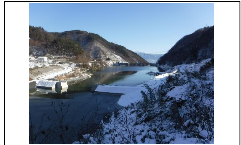
4 貯水池(上流からの全景)
