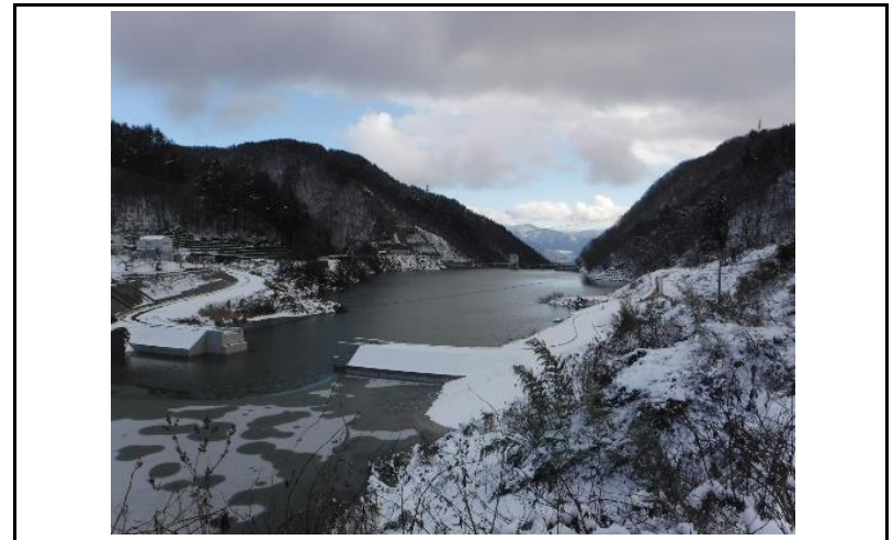
4 貯水池(上流からの全景)
