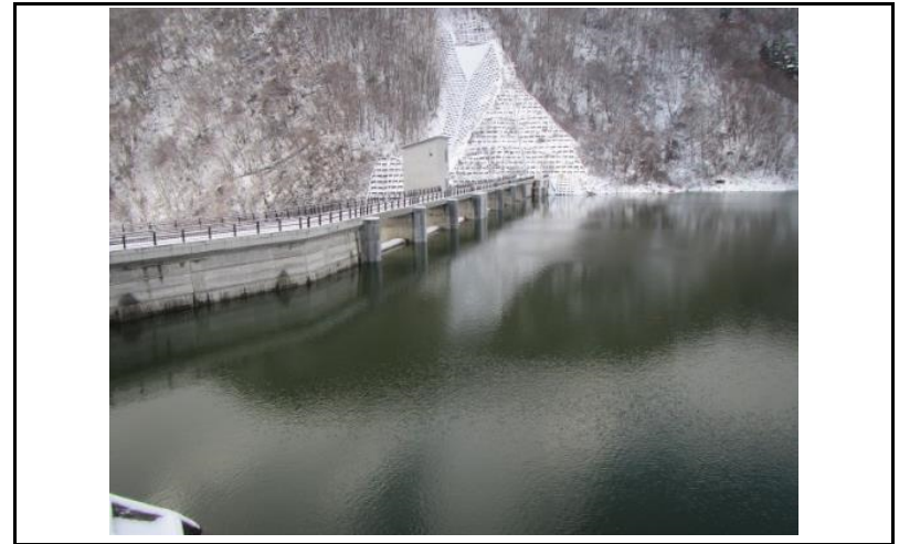
2 ダム上流面(左岸から)
