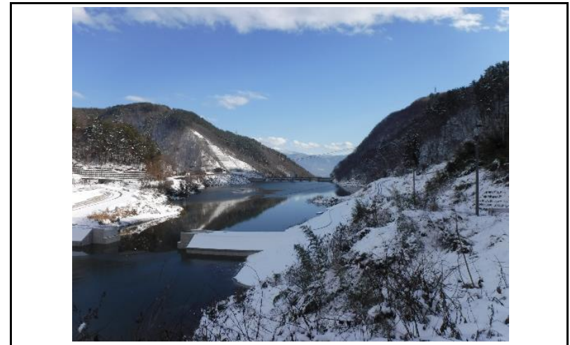
4 貯水池(上流からの全景)
