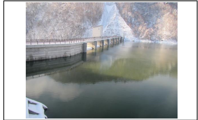
2 ダム上流面(左岸から)
