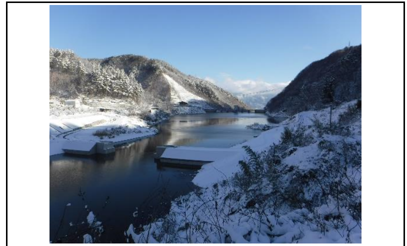
4 貯水池(上流からの全景)
