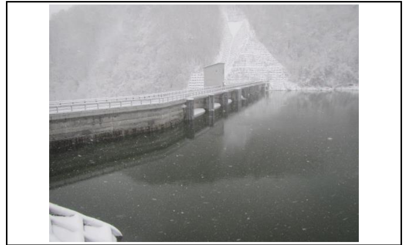
2 ダム上流面(左岸から)
