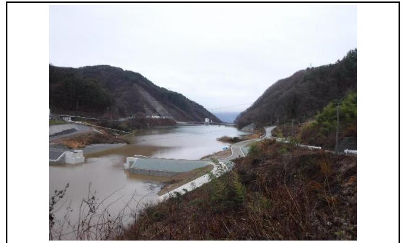
4 貯水池(上流からの全景)
