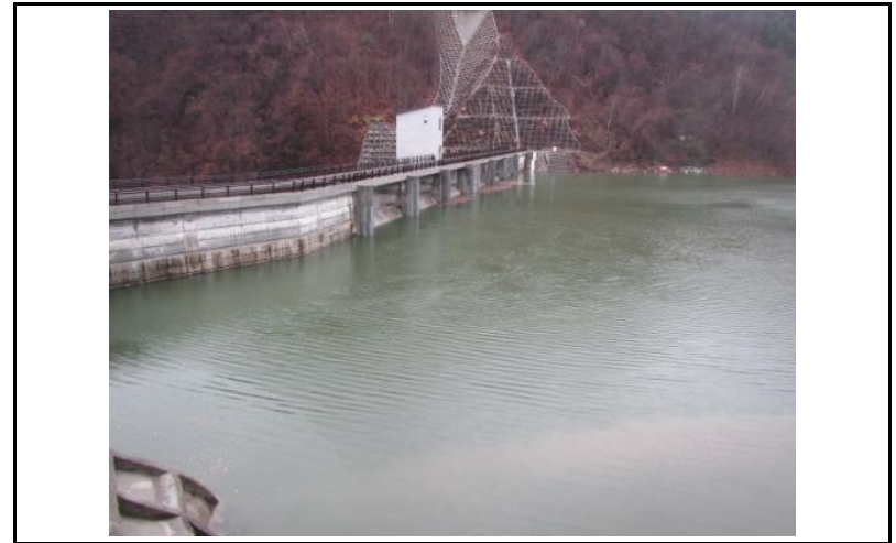
2 ダム上流面(左岸から)
