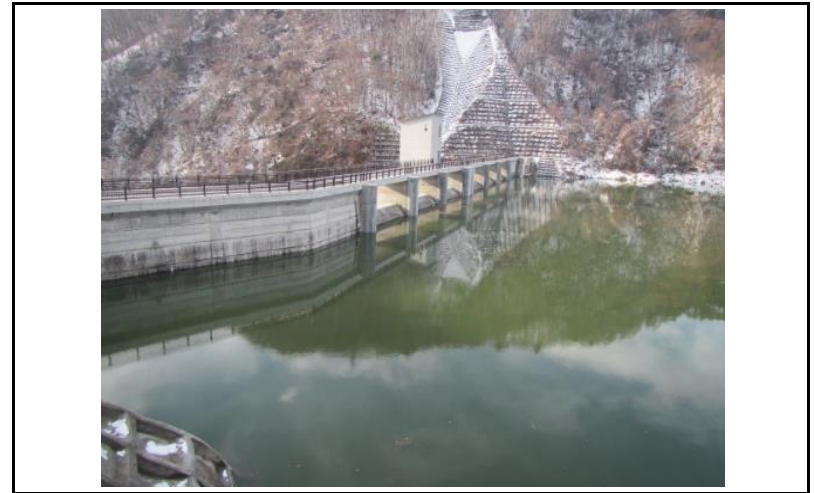
2 ダム上流面(左岸から)
