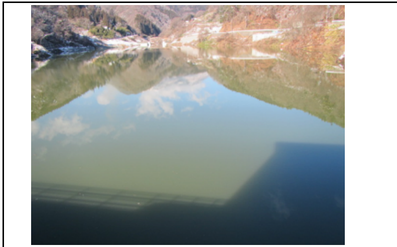
3 貯水池(ダムから上流)
