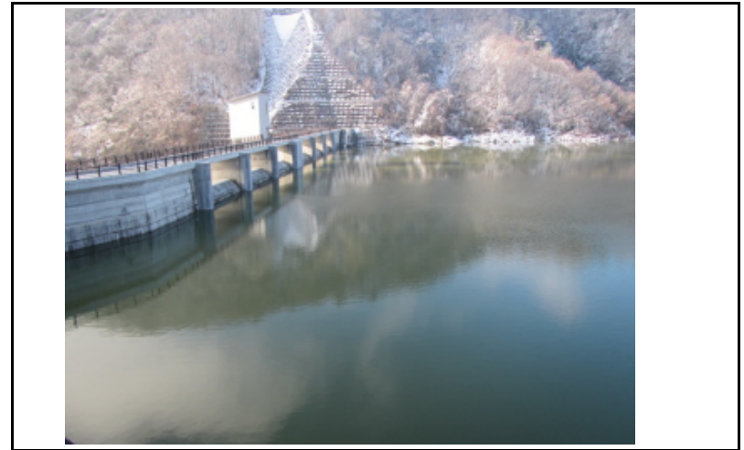
2 ダム上流面(左岸から)
