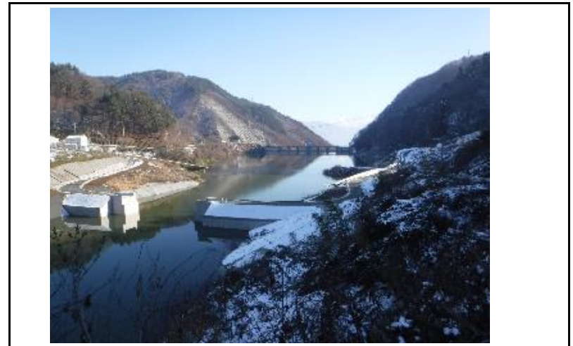
4 貯水池(上流からの全景)
