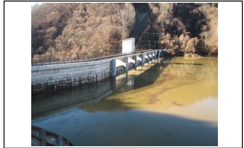
2 ダム上流面(左岸から)
