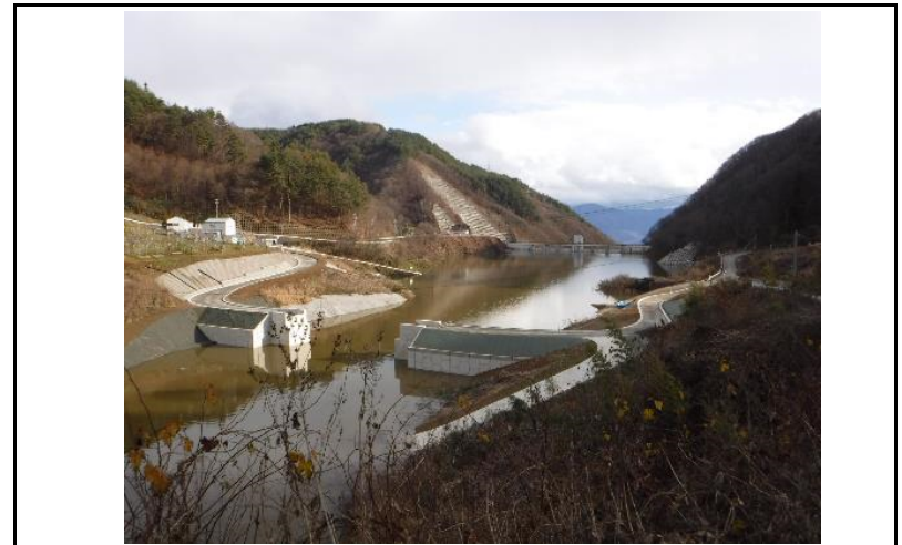
4 貯水池(上流からの全景)
