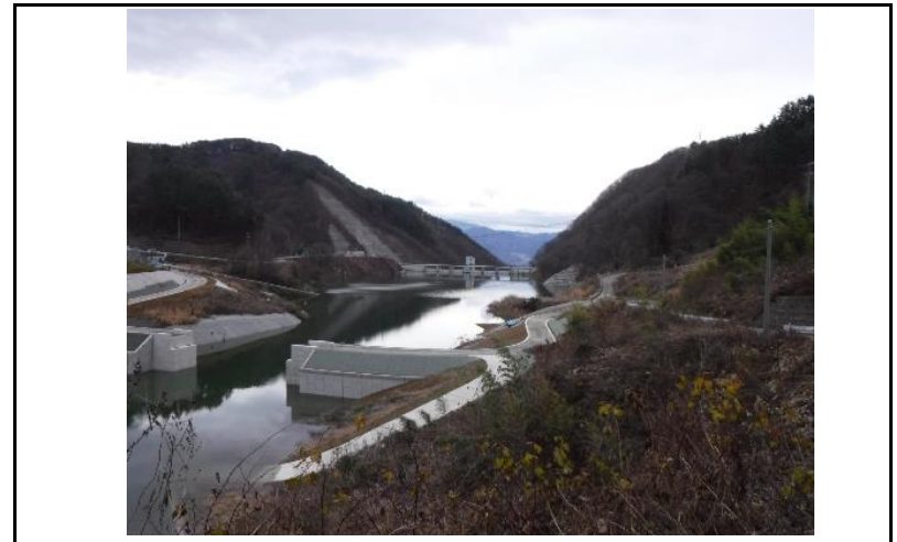
4 貯水池(上流からの全景)
