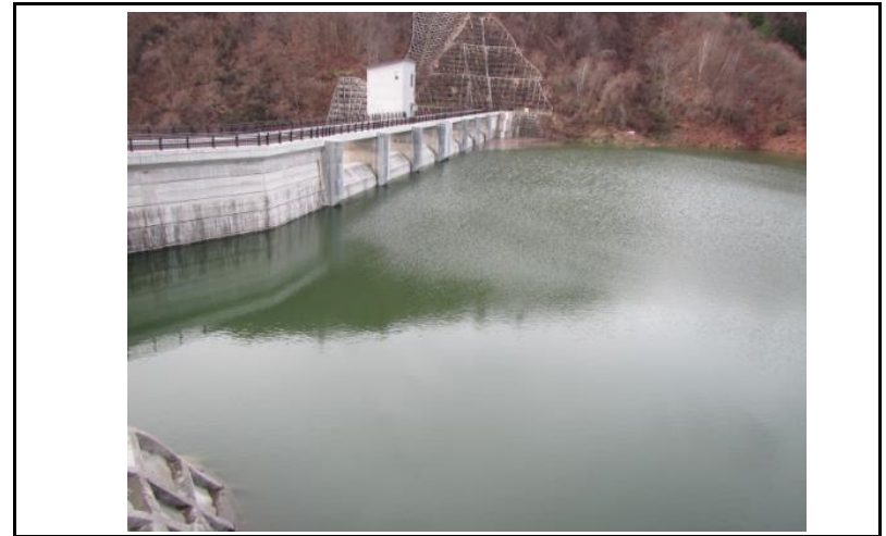
2 ダム上流面(左岸から)
