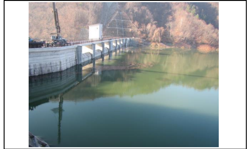
2 ダム上流面(左岸から)
