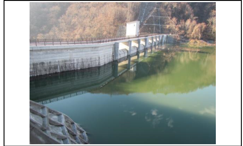
2 ダム上流面(左岸から)
