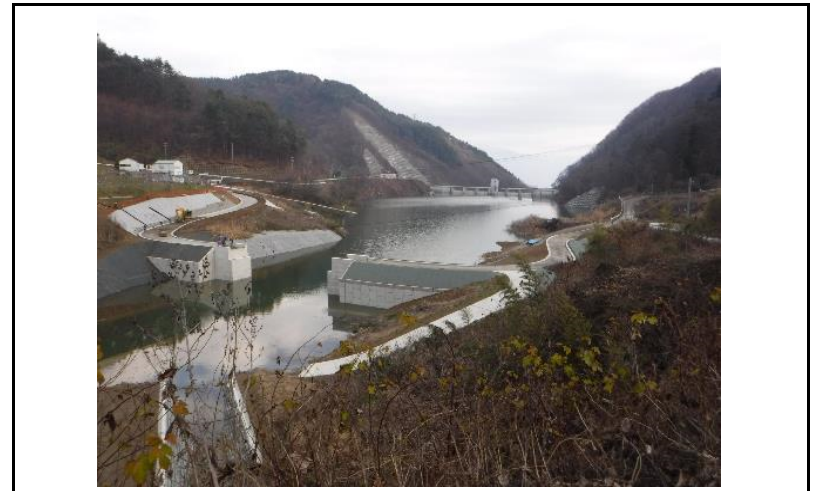
4 貯水池(上流からの全景)
