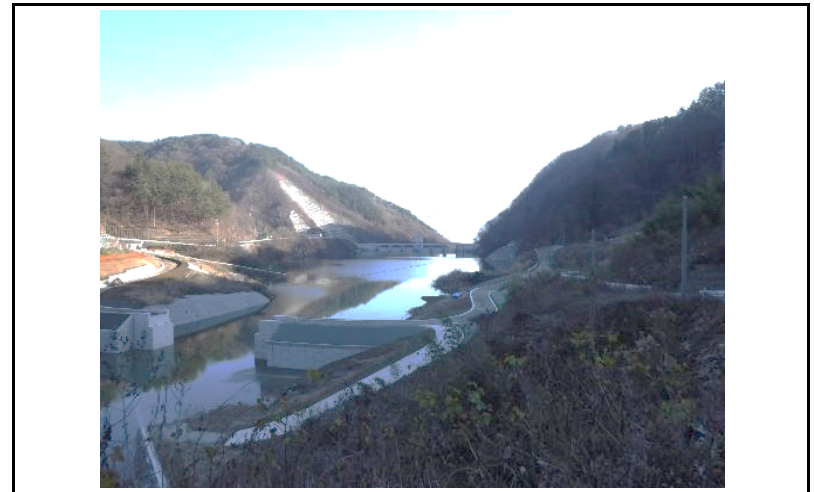
4 貯水池(上流からの全景)
