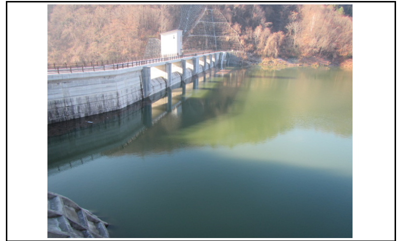
2 ダム上流面(左岸から)
