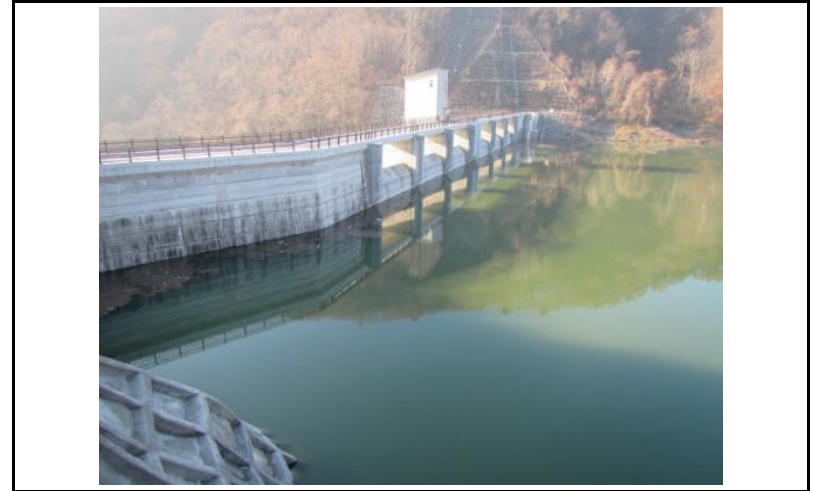
2 ダム上流面(左岸から)
