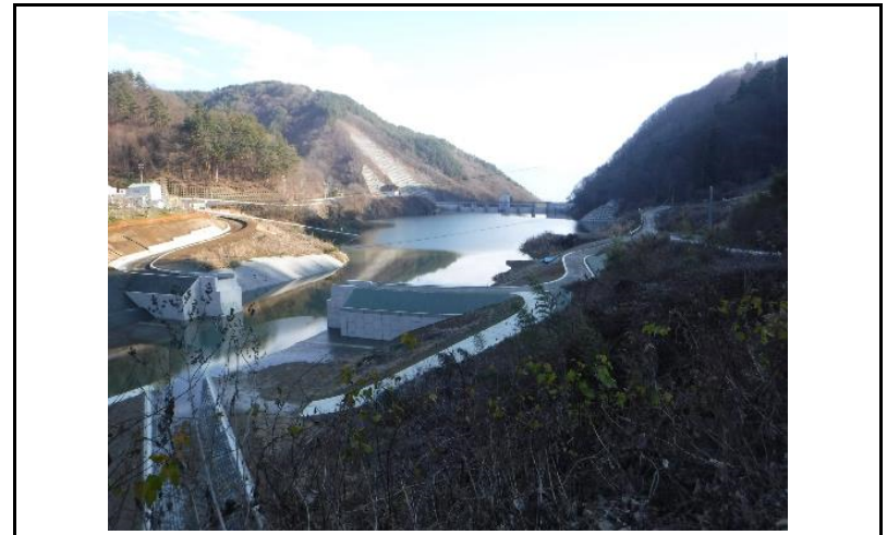
4 貯水池(上流からの全景)
