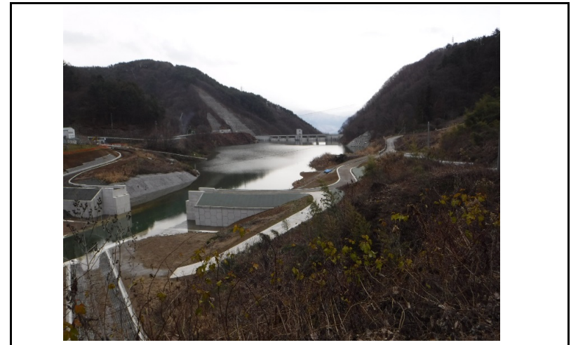
4 貯水池(上流からの全景)
