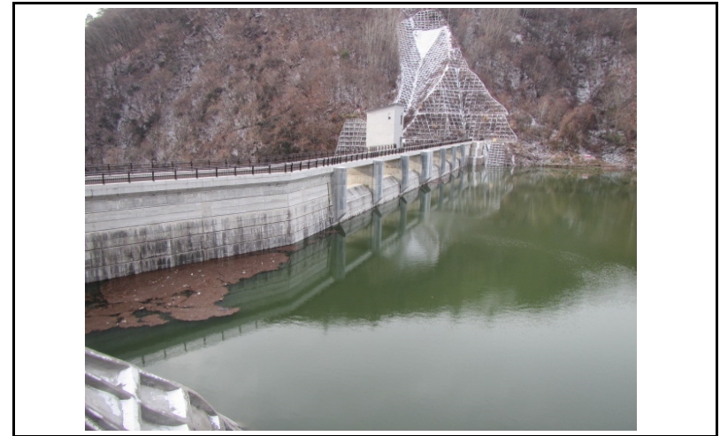
2 ダム上流面(左岸から)
